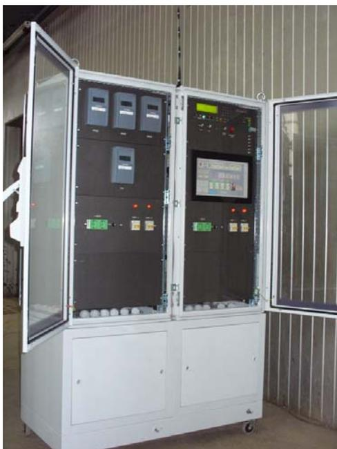
Рис.3. Система управления и защиты СТК 35 кВ
