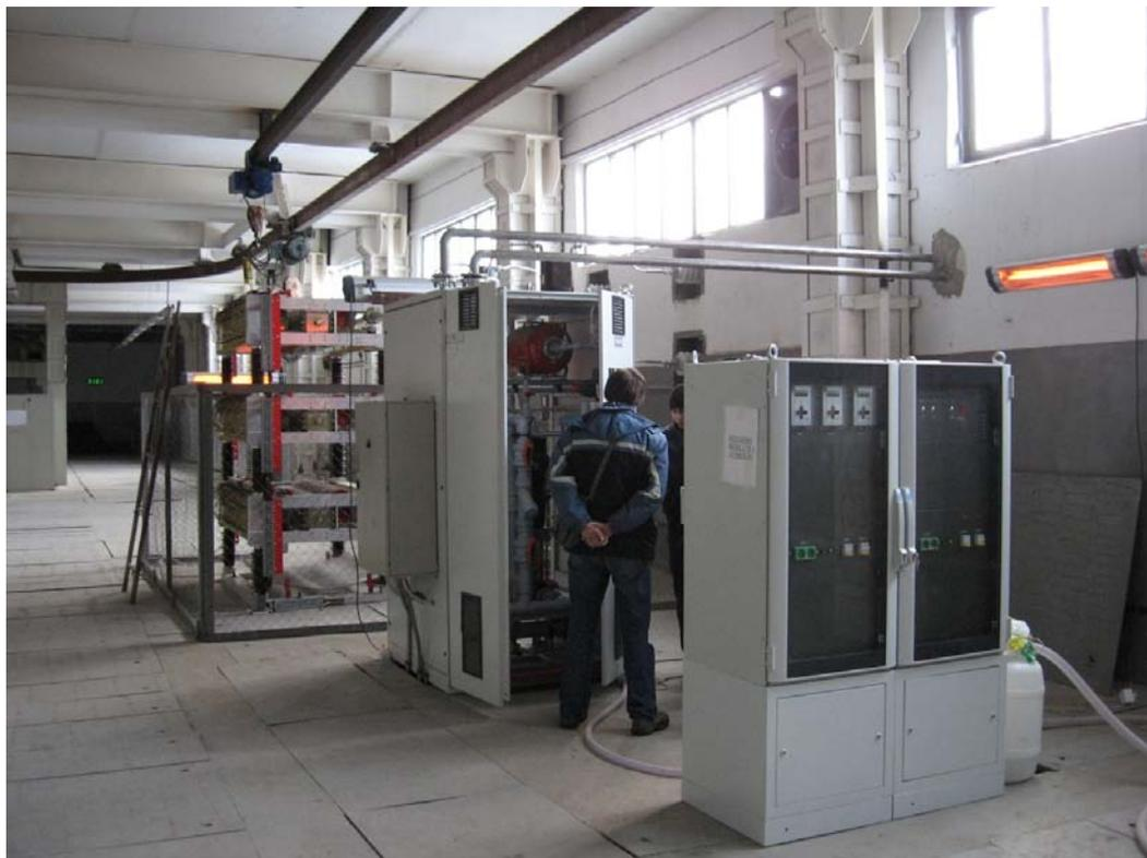
Оборудование внутренней установки: тиристорный вентиль, шкаф системы водяного охлаждения, система управления и защиты
