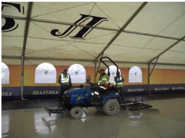
Укладка DENSIPHALT на территории контейнерного терминала
